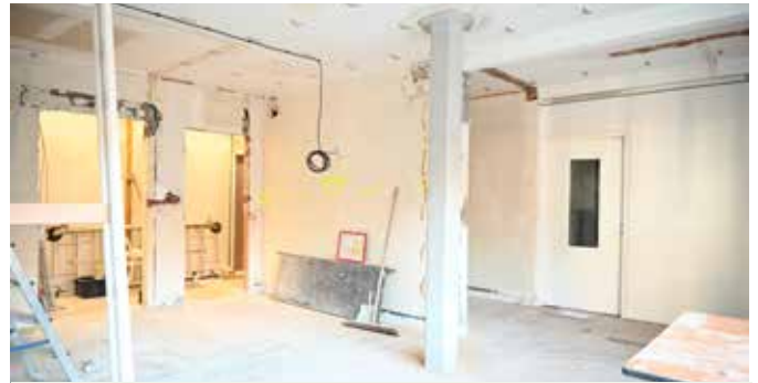
Les anciens bureaux du CCAS au rez-de-chaussée de l'Hôtel de Ville en cours de rénovation par les services techniques..
