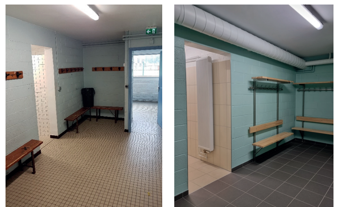
Les vestiaires du complexe Depoortere Avant / Après
