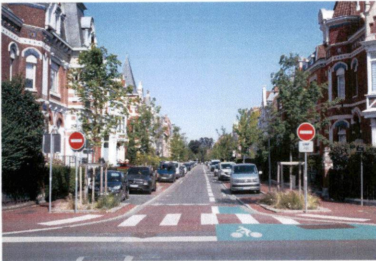
Amélioration des déplacements doux rue Delory à Orléans ▲
