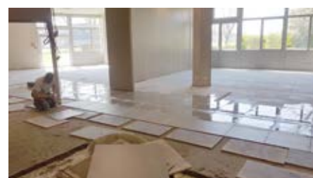
Un nouveau carrelage a été posé à l'espace Rocheville.
